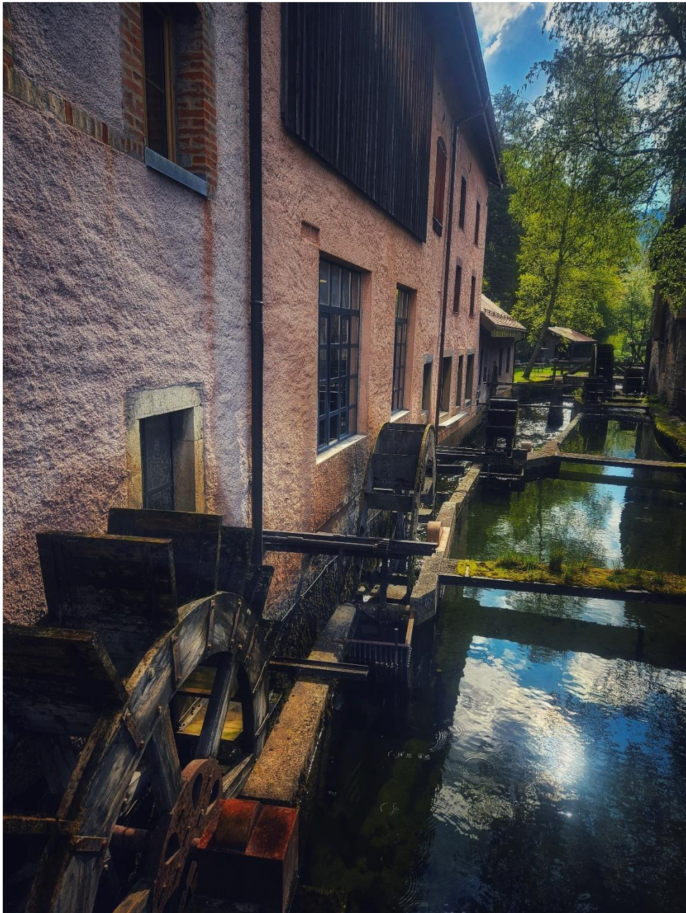
Vue sur le canal ramifié de l'Orbe et les roues hydrauliques montées
